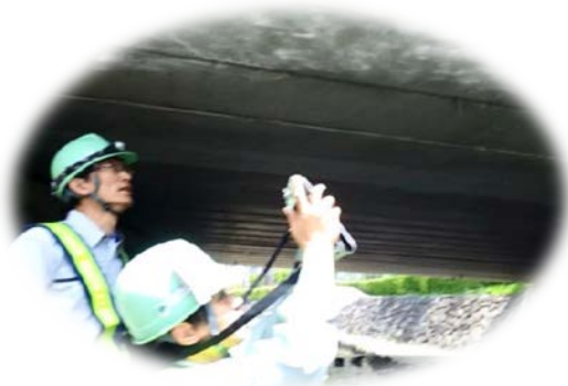
【タブレットによる点検】
