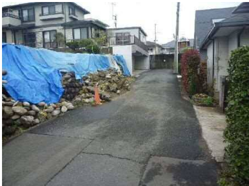
図参 3.6-⑧ 変位量が小さいものの例
