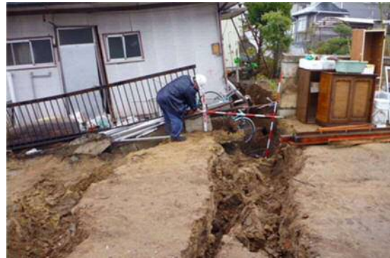
図参 3.6-⑨ 変位量大きいものの例
