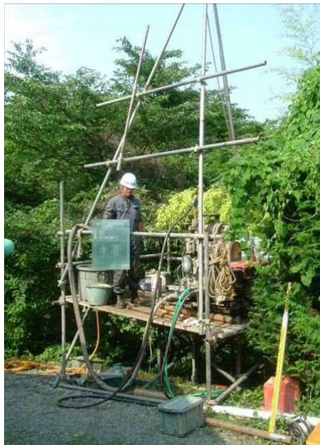
図参6.4-① 調査ボーリング実施風景
