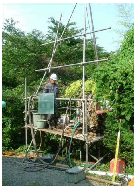
図参3.2-① 調査ボーリング実施風景
