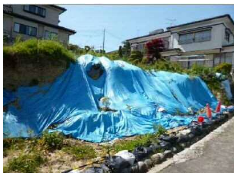
図参 1.1-⑫ ひな壇部分の変形被害が発生した地区の被害写真
