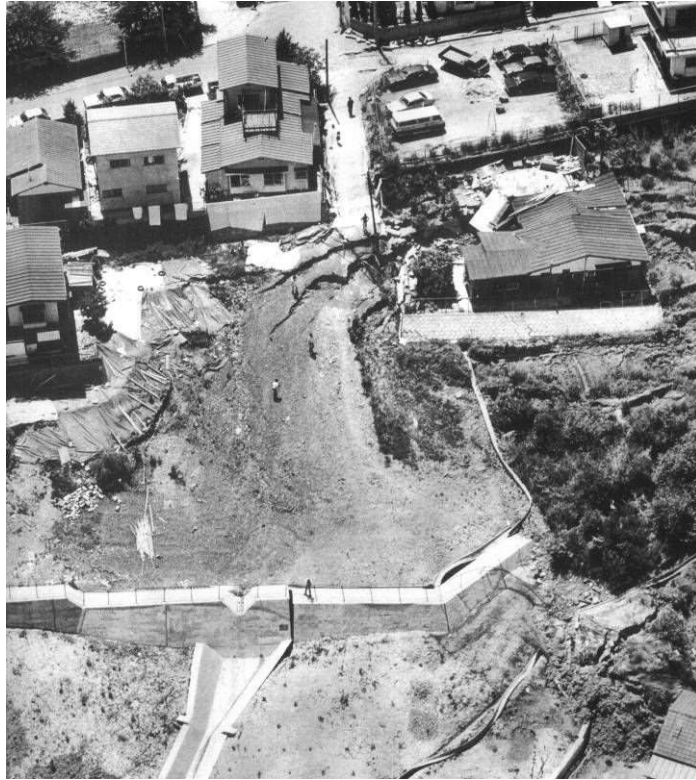
図参 1.1-① 1978年宮城県沖地震による盛土造成地の被害 (撮影、提供：河北新報社)
