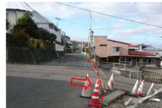
(c) 道路面の水平変位
