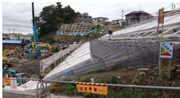
図参 6.1-⑧ グラウンドアンカー工法（現場打ちのり枠工+グラウンドアンカー工）の施工状況（NK地区の例）
