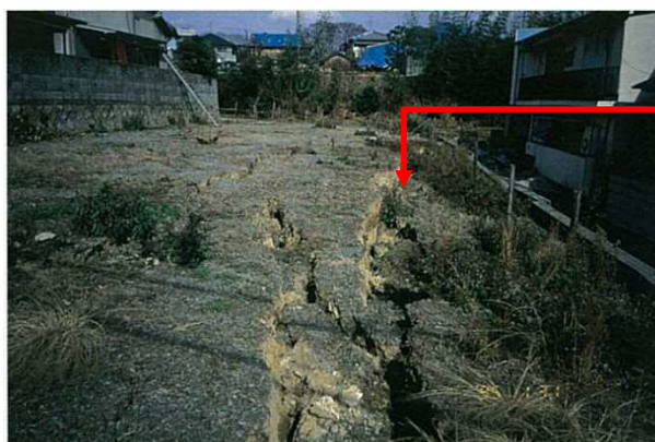
図参 1.1-⑥ 西宮市における盛土造成地の変動に伴う被害（その3）
