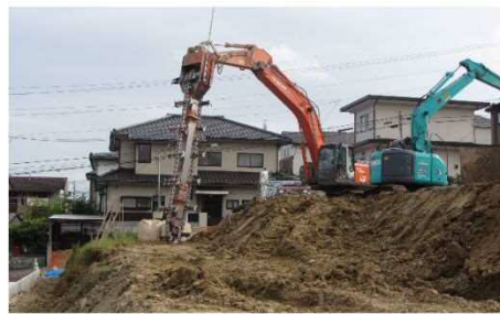
図参 6.1-② 固結工法（中層混合処理工）の施工機械（N地区の例）
