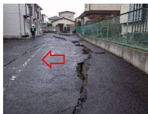
(a) 頭部のクラック
