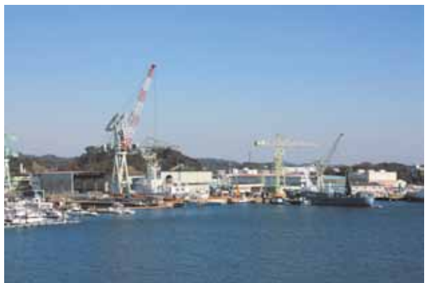
塩釜港の造船所
