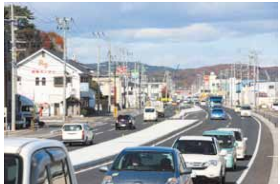
整備中の八幡築港線
