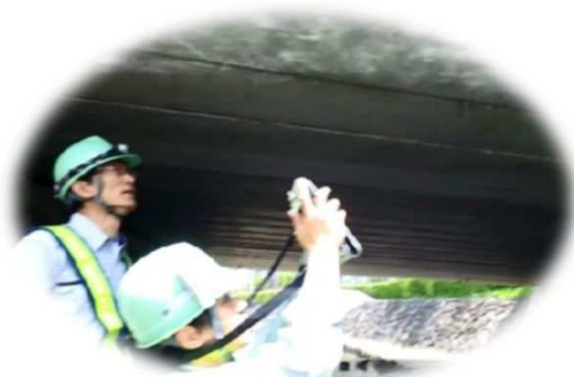
【タブレットによる点検】
