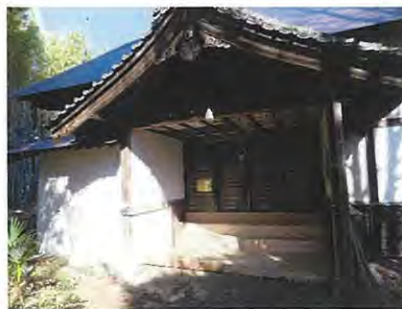
式台部分の仮復旧、鍵設置
