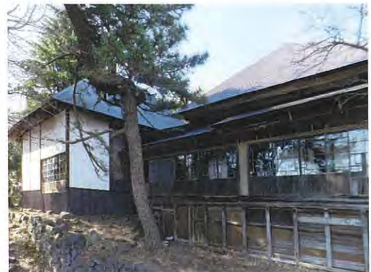
外壁・窓ガラス等の補修
