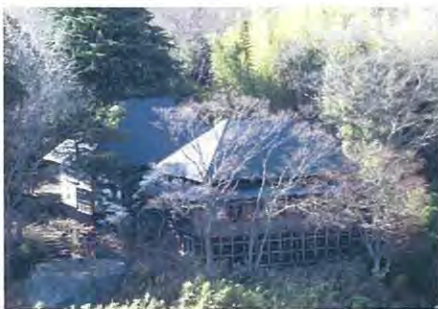
屋根の改修（鋼板敷設）
