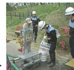
清水沢公園の耐震性貯水槽で給水する様子 ▶
