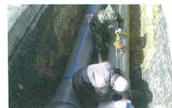
▲耐震管布設工事の現場 （提供：日本ダクタイル鉄管協会）
