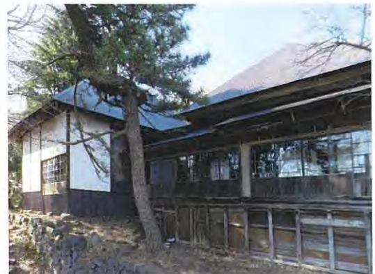
外壁・窓ガラス等の補修
