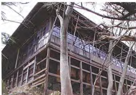
勝画楼棟（懸けづくり部分）
