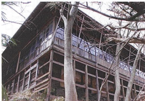
勝画楼棟（懸けづくり部分）
