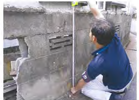
▲危険ブロック計測中
