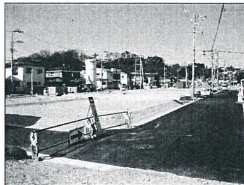
▲藤倉地区被災市街地復興土地区画整理事業(藤倉二丁目) 4月より、東側工区の一部宅地(7件)の引き渡しが始まっています。
