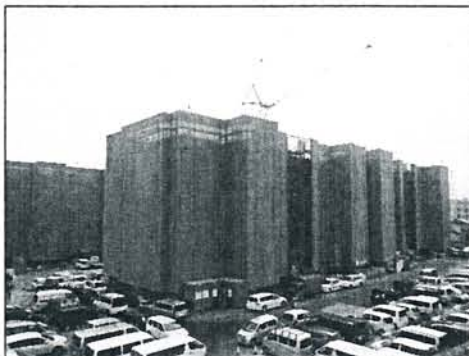
▲清水沢地区災害公営住宅 東西170戸のうち東工区31戸が6月に完成します。
