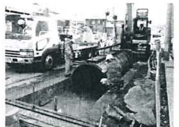
△新浜町杉の下・藤倉二丁目の下水道(雨水幹線)工事 ライフライン整備にも尽力していきます。
