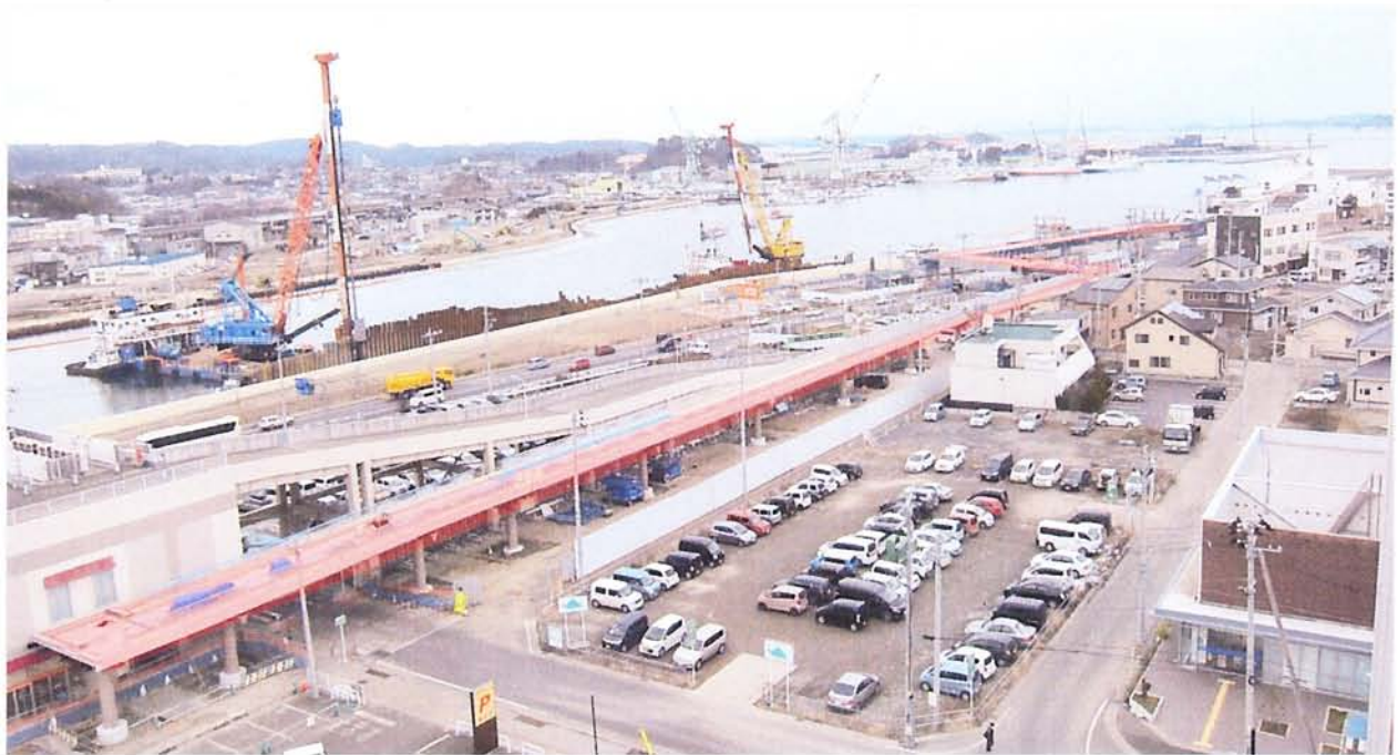
▲全景（本塩釜駅側より）
