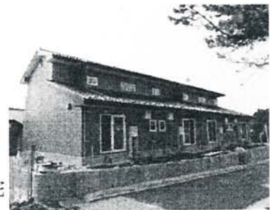
桂島地区 災害公営住宅
