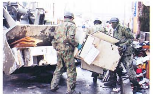
道路の啓開作業
