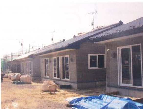
△寒風沢地区災害公営住宅
