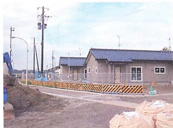
△朴島地区災害公営住宅
