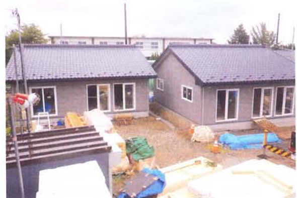
△桂島地区Ⅱ期災害公営住宅
