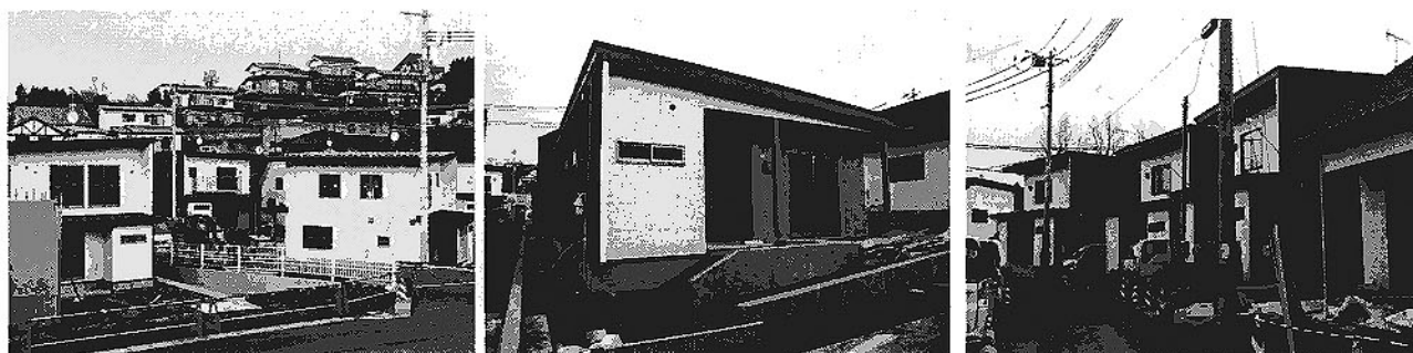
平成25年12月24日時点の進捗状況です。着々と整備が進んでおります。
