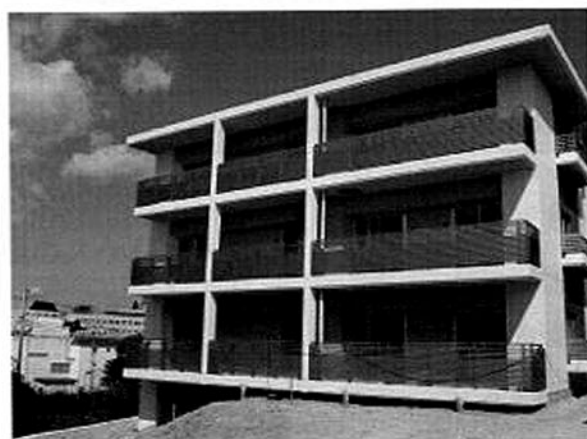
錦町地区災害公営住宅（3号棟）
