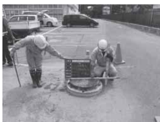
▲マンホールの復旧工事
