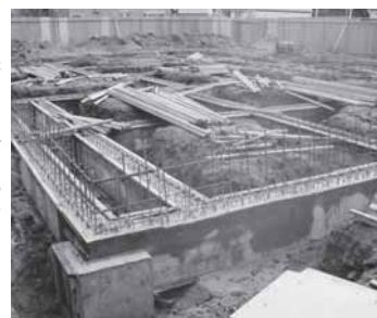
▲基礎工事の様子
