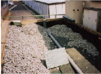
集水管・砕石埋戻し(空隙率 30%)
