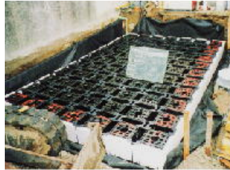
ブロック設置(空隙率 95%)
