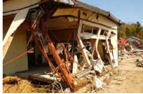
全壊（公民館浦戸分館）
