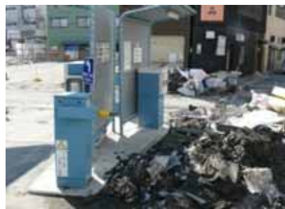
海岸通顧客利便施設の浸水被害
