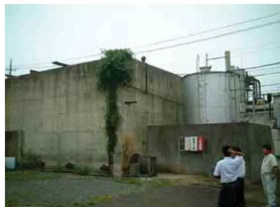
図5-3 既設貯蔵タンク
