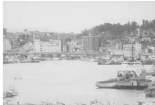
塩釜港港奥部
