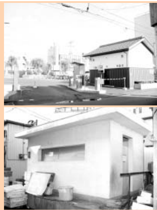
塩竈海岸通駐車場内トイレ(上段)の供用開始で撤去が行われる旧公衆トイレ(下段)
