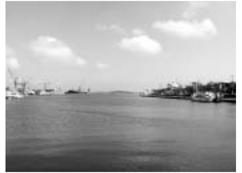
仙台塩釜港 (塩釜港区)
