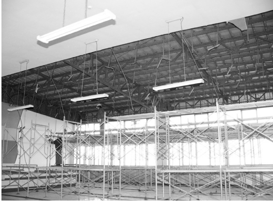
復旧工事中の大会議室（塩竈市魚市場）
