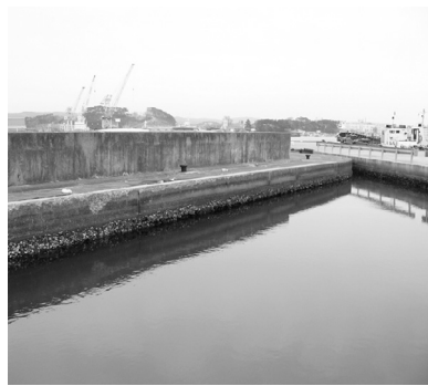
防潮堤 (港町一丁目)
