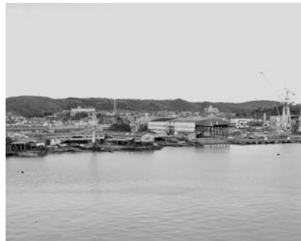
港奥部（北浜地区）
