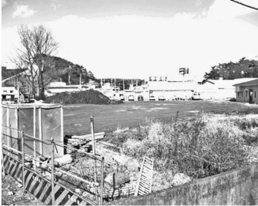
藤倉雨水ポンプ場予定地
