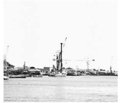
港奥部（北浜地区）
