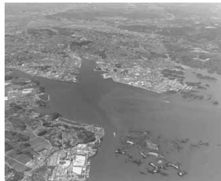
特定重要港湾仙台塩釜港塩釜港区
