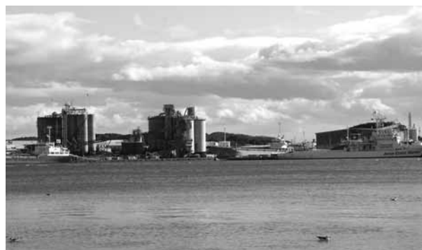
仙台塩釜港（塩釜港区）
