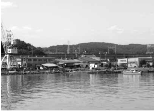
緑地護岸整備地区（北浜）
