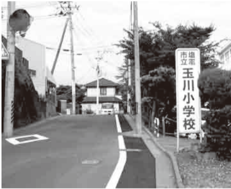
カラー舗装整備された通学路 (玉小付近)
