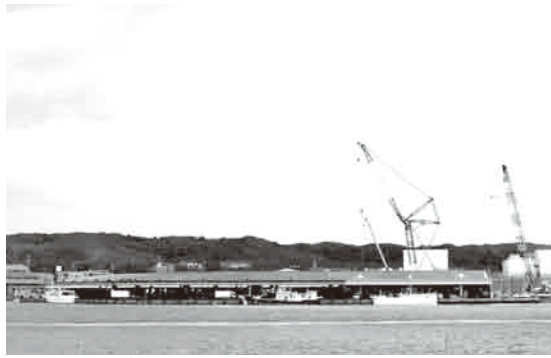
新築工事が議決された塩竈市魚市場
