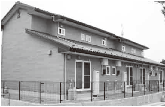
災害公営住宅（桂島）
