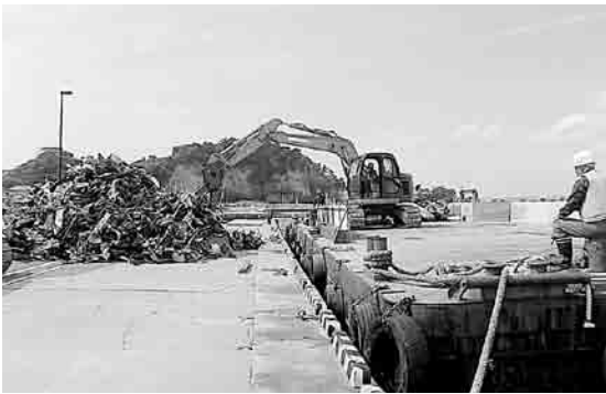
浦戸地区瓦れき撤去業務
