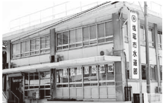
塩竈市水道部
