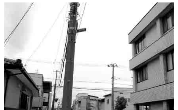
LED化された防犯灯（北浜地区）
