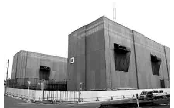
建設中の災害公営住宅（清水沢）
