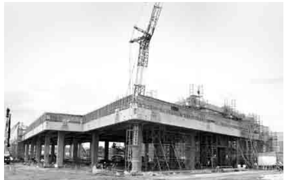
建設中の新塩竈市魚市場 A棟
