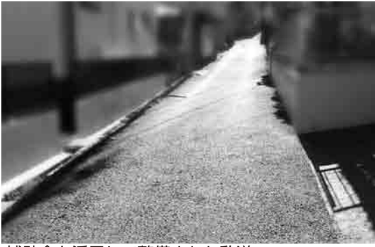
補助金を活用して整備された私道
