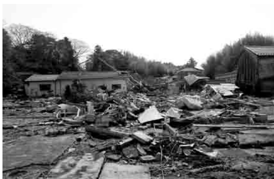
被災した浦戸の状況
