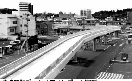
津波避難デッキ (マリンデッキ塩釜)
