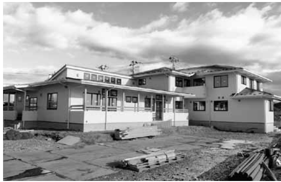
利府町に建設中の地域生活支援拠点施設
