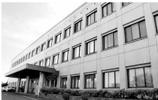
建設基礎調査事業が行われる塩竈市立病院
