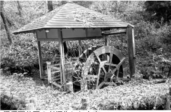
伊保石公園の老朽化した水車
