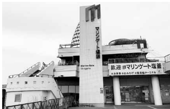
今回撤去するマリンゲート塩釜西側エレベーター棟及び階段
