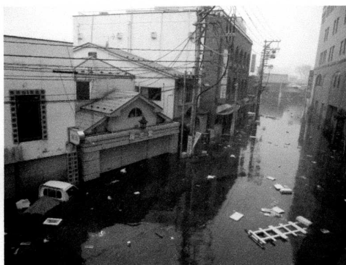
津波による冠水状況・吾番館周辺
