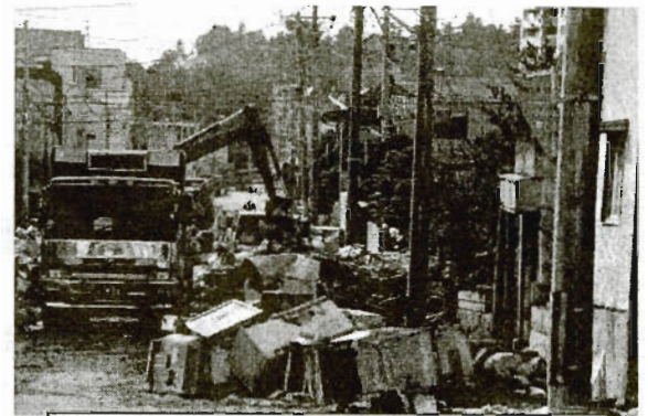
港町地区のガレキ撤去を進めています
