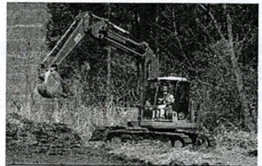
28日仮設住宅60戸建設開始
