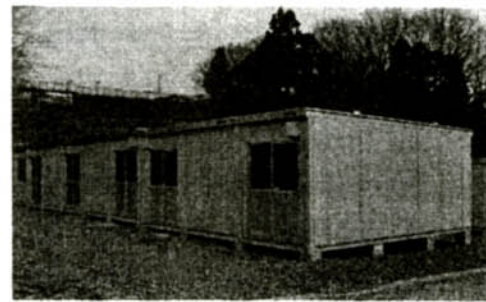
仮設住宅の建築が進んでいます 4/7 午前撮影
