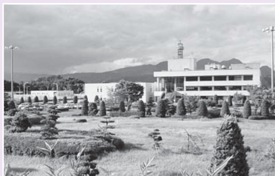
▲南部山浄水場（白石市）
