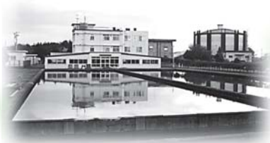
▲ダムからは浄水場でわたしたちが使える水になります (権現堂浄水場)
