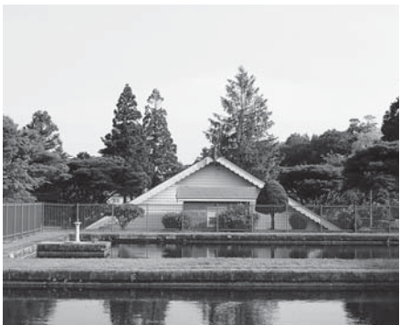
▶ 権現堂浄水場低区配水池
