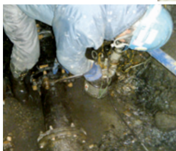
▼ 配水管（口径100mm）の修理工事
