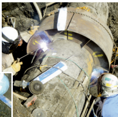
▲ 導水管（口径700mm）の修理工事
